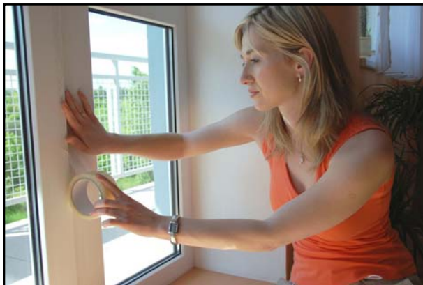
Obr. 2: Utěsnění oken lepící páskou.
